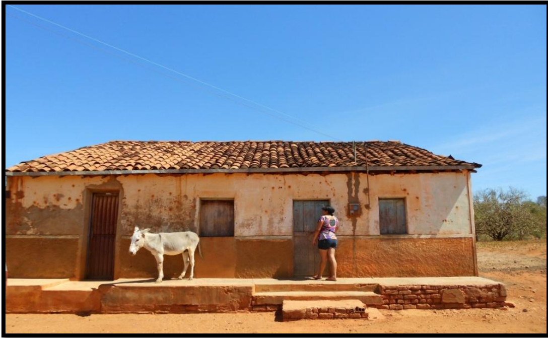
Fig. 13. Casa na comunidade quilombola Tapuio
