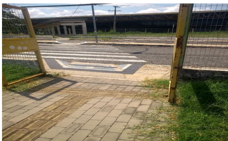
Figura 4 - Faixa de pedestre com piso tátil de alerta e calçada rebaixada
