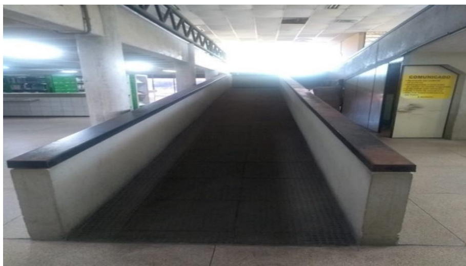
Figura 8 – Rampa para acesso ao piso superior
