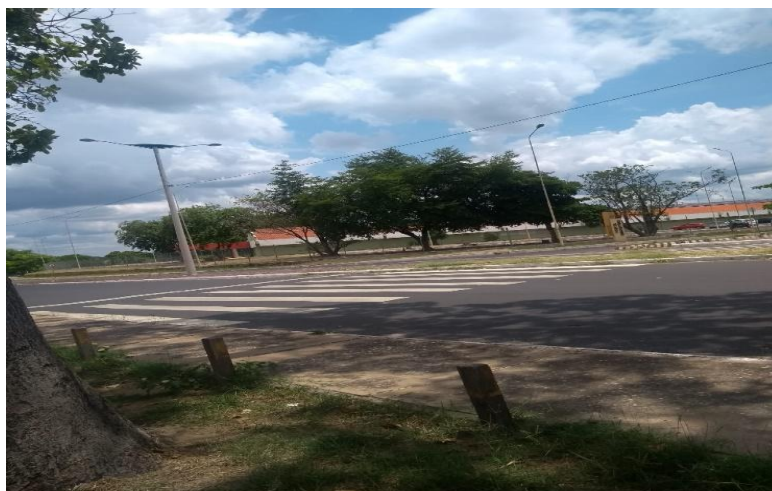
Figura 5 - Faixa de pedestre sem piso tátil de alerta e direcional e sem calçada rebaixada
