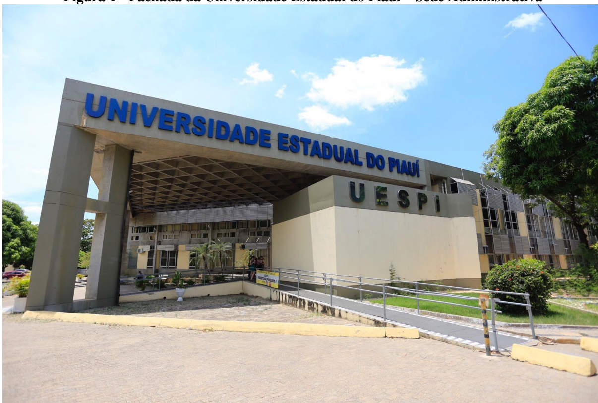
Figura 1 - Fachada da Universidade Estadual do Piauí – Sede Administrativa
