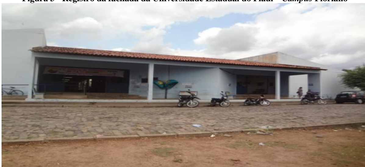
Figura 3 - Registro da fachada da Universidade Estadual do Piauí – Campus Floriano
