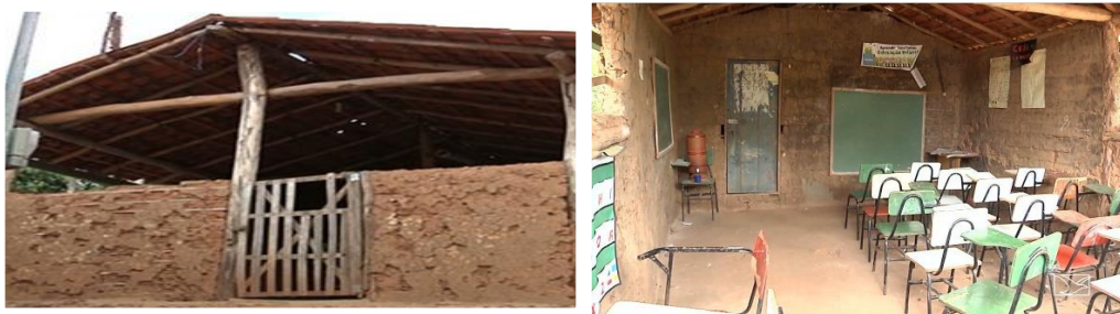
Figura 4 – Caracterização do tipo de escola de taipa - Escola Municipal Raimundo Paixão no povoado Oiteiro dos Félix na zona rural de Codó (MA)
