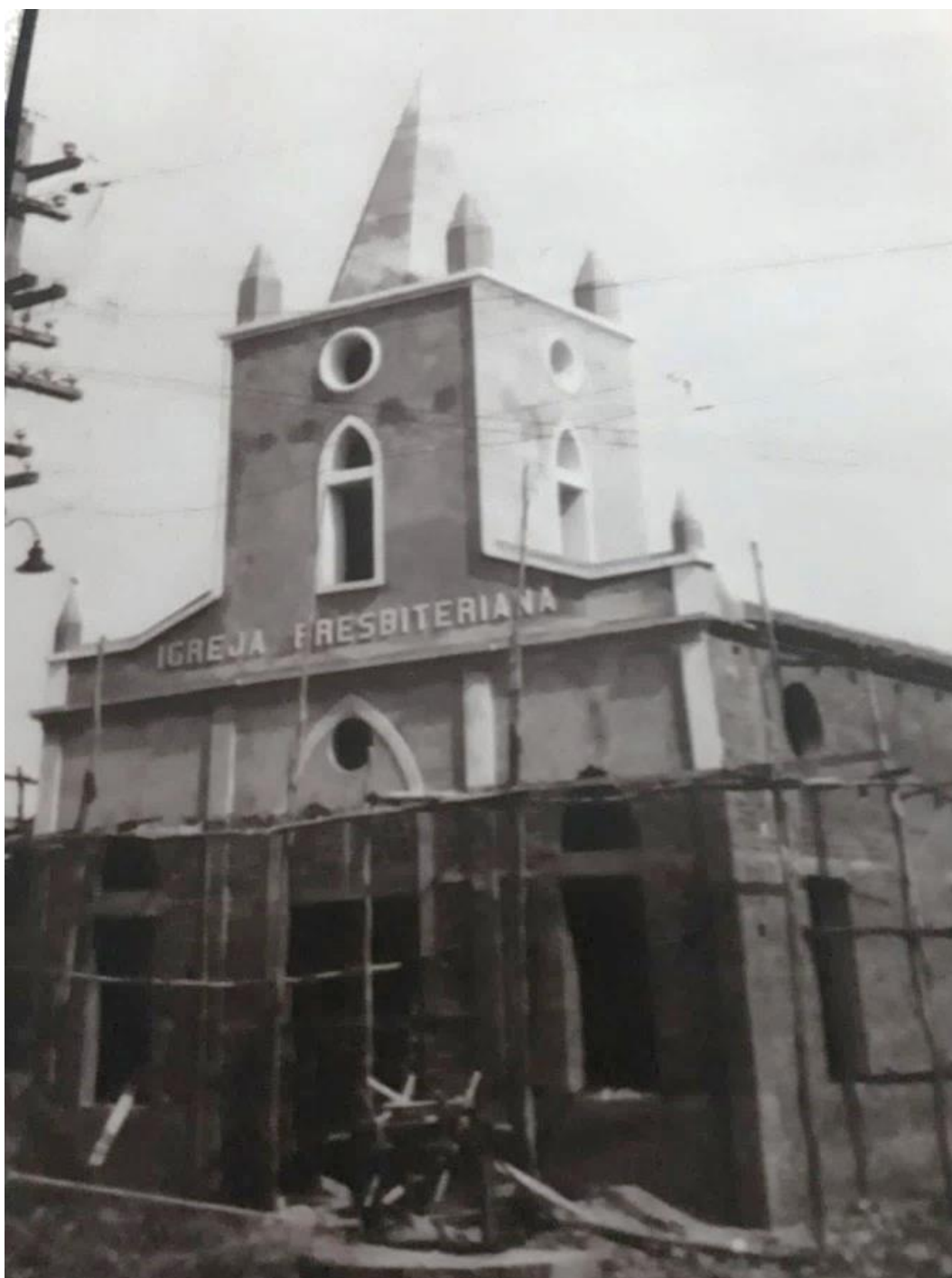
Fotografia 33 – Templo em construção da Primeira Igreja Presbiteriana de Teresina (n/d)
