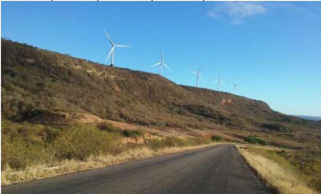
Figura 5 - Escarpas da Chapada do Araripe no município de Caldeirão Grande do Piauí
