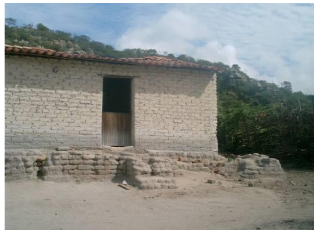
Figura 26. Padrão construtivo: em adobe, sem revestimento e poucas aberturas.
