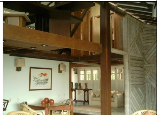
Figura 65. Vista interna da estrutura em madeira do mezanino e dos painéis de carnaúba. Foto: Sandra Alexandria, 2005.
