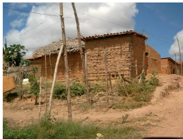
Figura 141. Habitações feitas em locais impróprios na periferia da cidade.
