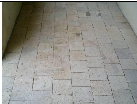
Figura 133. Detalhe do piso original em ladrilho cerâmico.
