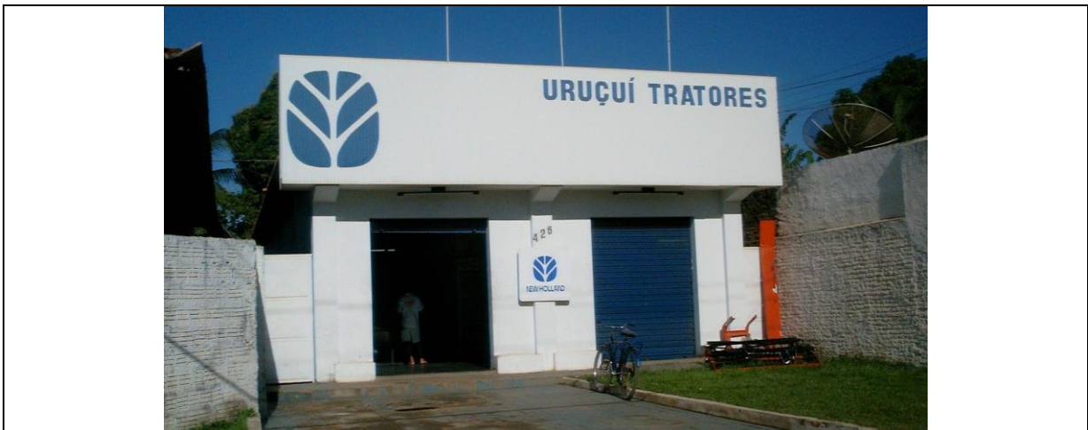
Figura 48. Fachada do galpão comercial onde funciona a Urucuí Tratores, em adobe.
