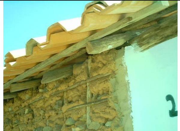
Figura 56. Detalhe da trama e das pedras colocadas na massa de enchimento.
