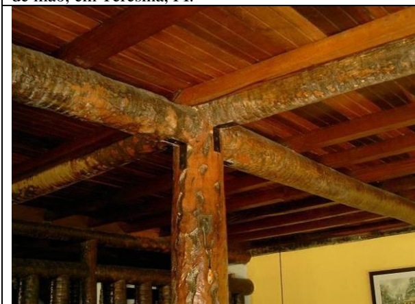
Figura 150. Detalhe do pilar e linhas de carnaúba, além do piso superior em madeira.
