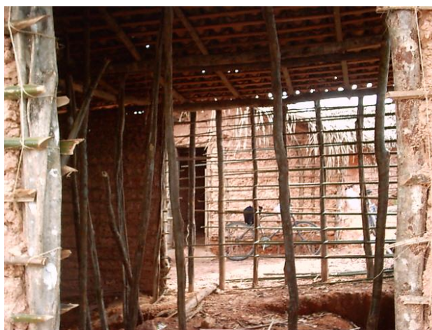
Figura 142. Fixação, com barbante, das varas horizontais de tala de coco no pau-a-pique. Foto: Sandra Alexandria, 2005.
