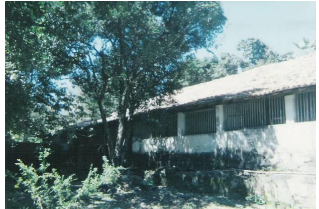
Figura 20. Fachada lateral da Faz. Olho D'água dos Pires, em Esperantina.
