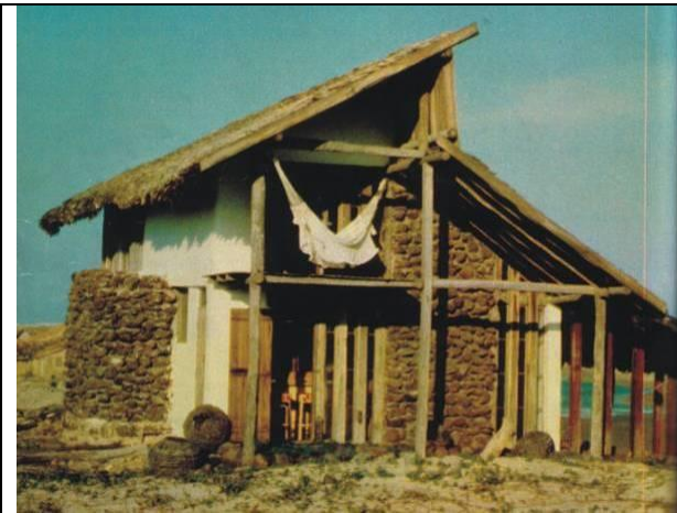
Figura 62. Fachada lateral da construção em taipa e mão, como era na época de sua construção. Foto: Guilherme Rezende, 1975.
