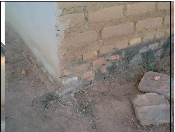
Figura 47. Detalhe do baldrame de tijolo maciço e parede de adobe.
