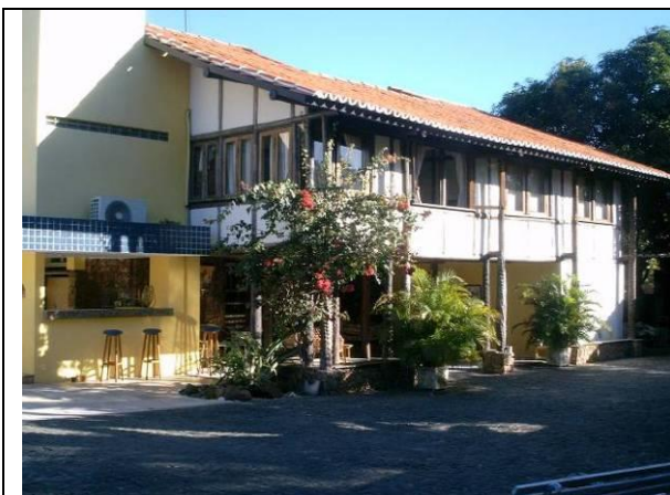
Figura 148. Vista geral da residência do Sr. Amaury Ribeiro, com estrutura de carnaúba e vedação de taipa de mão, em Teresina, PI.
