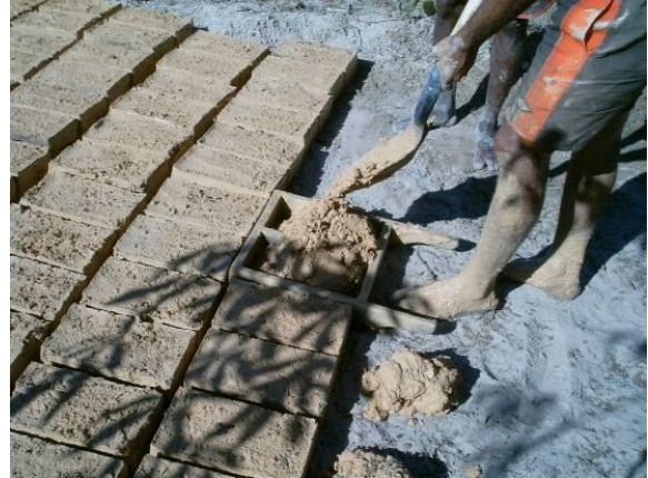
Figura 42. Adobes sendo enformados: o barro é colocado nas fôrmas com o auxílio de pá.
