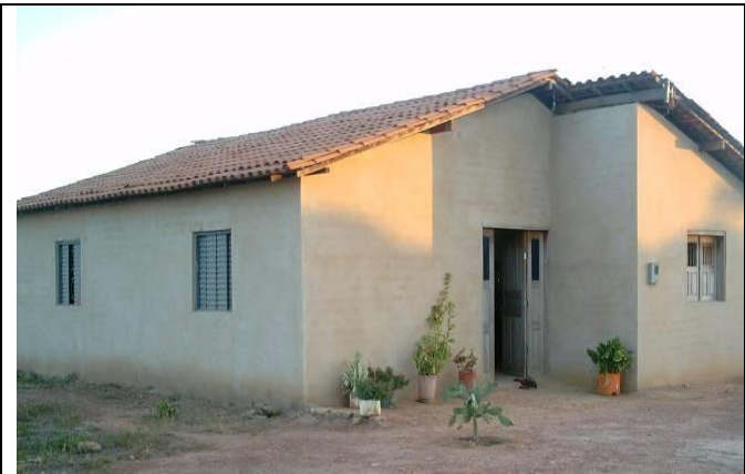
Figura 46. Vista residência do Sr. Antônio Pereira Saraiva, em adobe.
