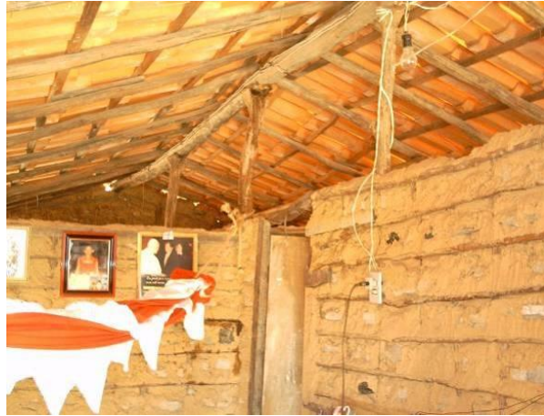
Figura 54. Detalhe da estrutura de madeira da cobertura.
