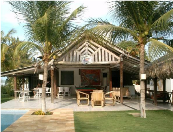
Figura 60. Vista da fachada da construção em taipa de mão e estrutura em palmeira de carnaúba.
