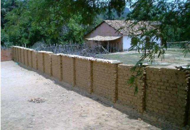
Figura 99. Exemplo de utilização do adobe em muros, em reboco, expostos às intempéries.
