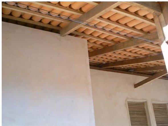
Figura 52. Vista interna da estrutura de cobertura de madeira e telhamento cerâmico apoiados diretamente sobre a parede de adobe.
