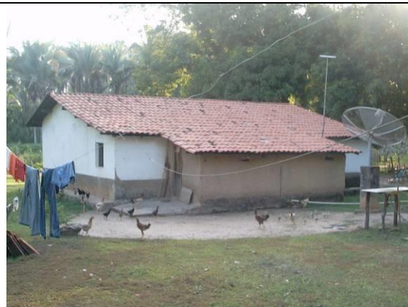
Figura 118. Vista do fundo da construção, com puxado feito em taipa de mão, onde funciona a cozinha da casa.
