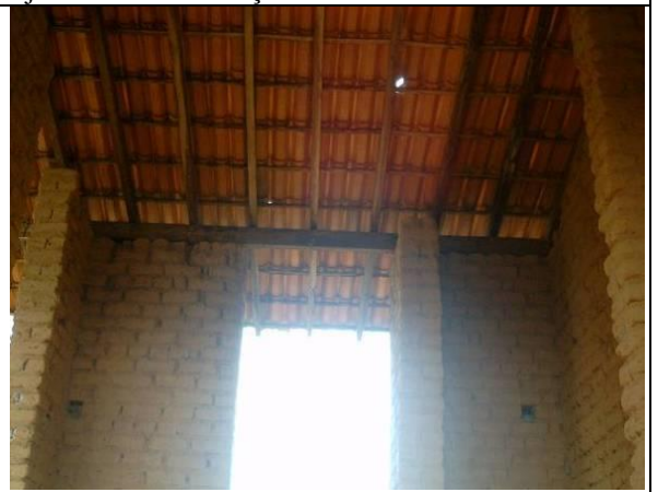
Figura 94. Cobertura em telha cerâmica apoiada no vigamento em madeira, sobre a parede de adobe.
