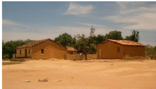
Figura 90. Casario erguido com adobes confeccionados com o solo avermelhado típico da região.
