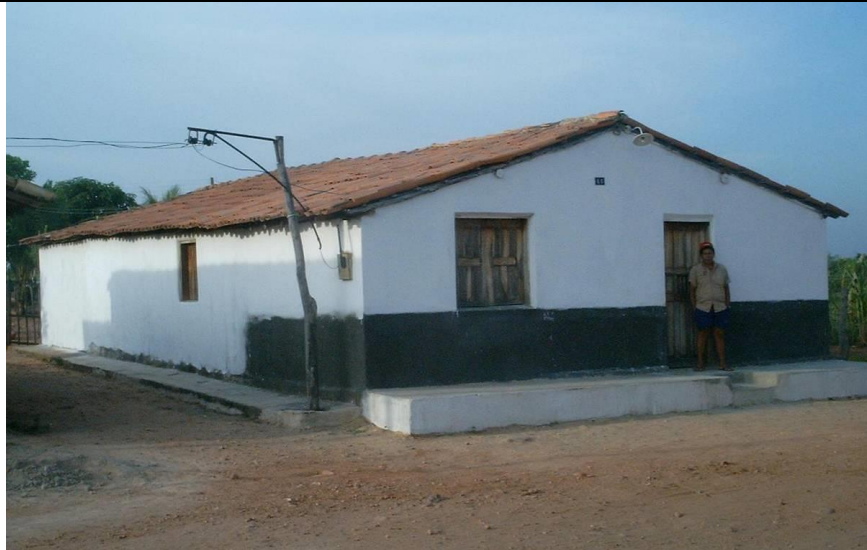
Figura 96. Vista da residência da Sra. Maria Rosa Soares da Silva, em adobe.
