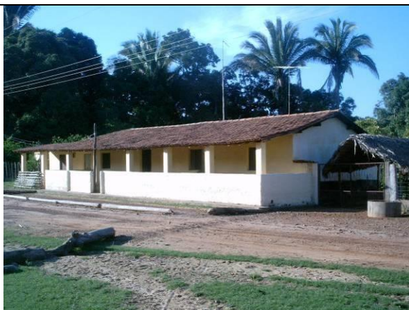
Figura 115. Vista da residência do Sr. Valdemir Nunes, de adobe, no povoado Zundão dos Camilos, União.
