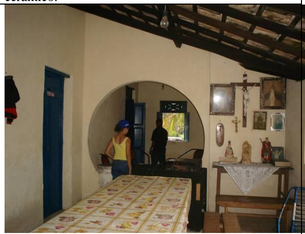
Figura 135. Vista interna da residência, com arcada em alvenaria cerâmica.
