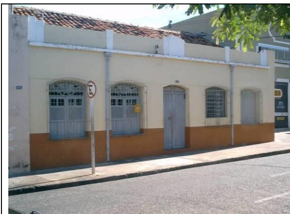
Figura 143. Vista residência do Sr. Geraldo Magela, construída no início do séc. XX de adobe.
