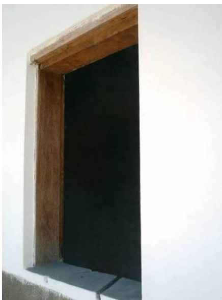
Figura 126. Detalhe da verga sobre a esquadria.
