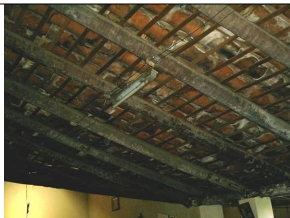
Figura 144. Detalhe do madeiramento de cobertura de carnaúba.
