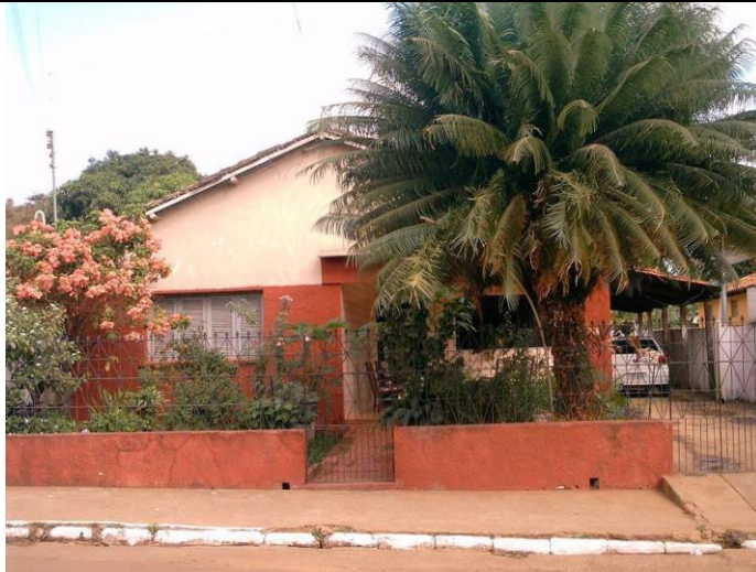
Figura 45. Vista residência da Sra. Antoninha Martins Cunha, em adobe.
