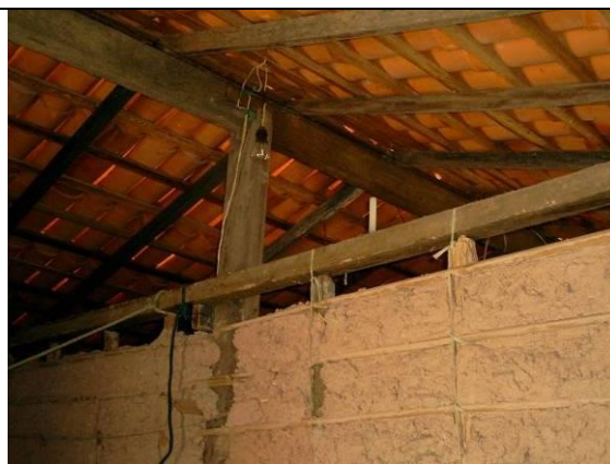
Figura 153. Detalhe das estacas amarradas com barbante na travessa de madeira.
