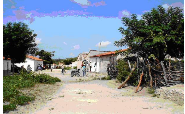
Figura 24. Vista do arruamento de Sítio Velho.
