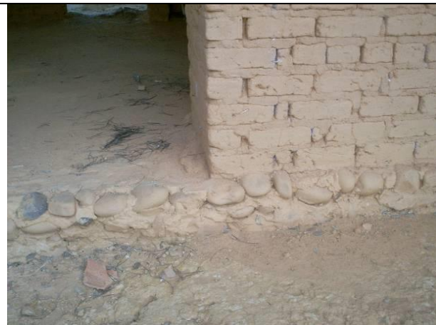
Figura 93. Detalhe da fundação que aflora sob a parede de adobe.
