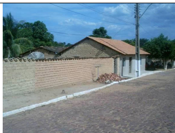
Figura 108. Muro lateral da construção, em adobe, com duas colorações de terra.
