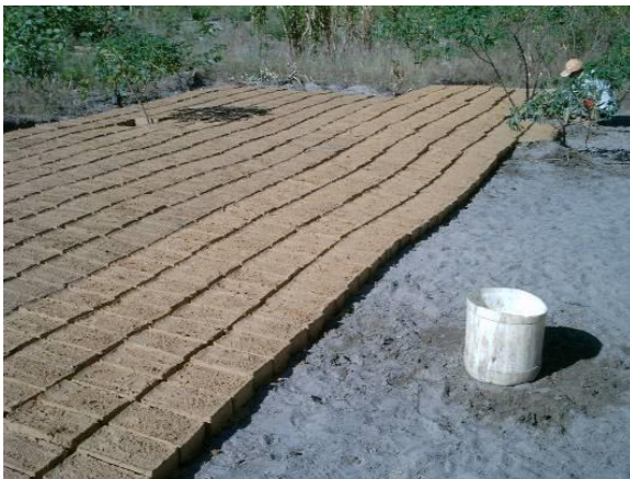
Figura 43. Tijolos de adobe secando sob o sol.
