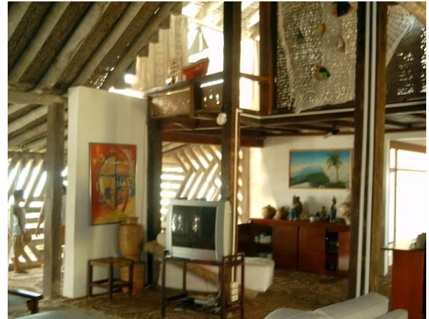
Figura 61. Vista do interior da construção em taipa de mão e estrutura de palmeira de carnaúba.
