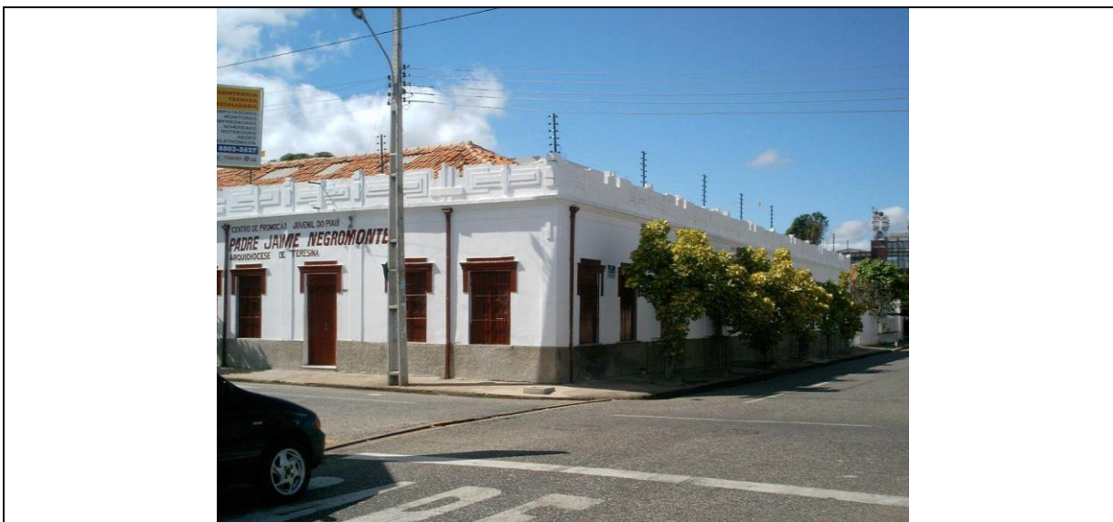
Figura 146. Vista do Centro de Promoção Juvenil do Piauí, prédio construído no início do séc. XX, de adobe.
