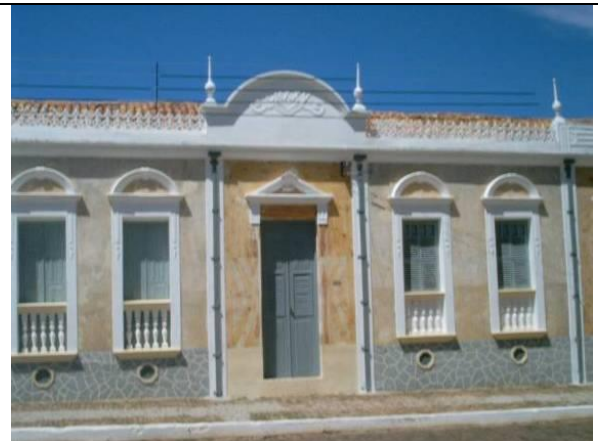
Figura 82. Detalhe da pintura em estuque na fachada do prédio.
