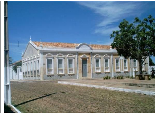
Figura 81. Vista principal do Museu Memorial Tertuliano Brandão Filho, em adobe.
