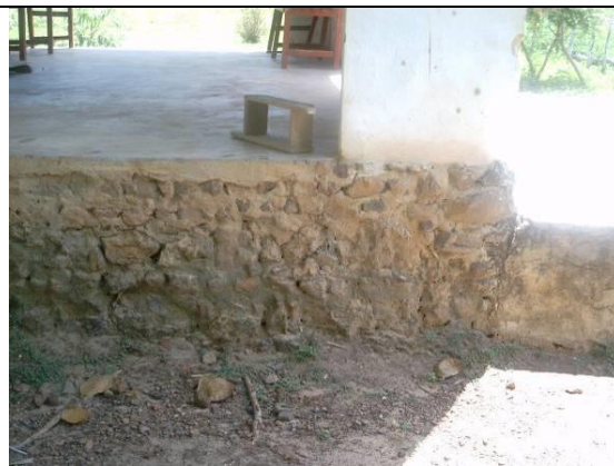
Figura 113. Vista da fundação de pedra que se eleva acima do nível do terreno.
