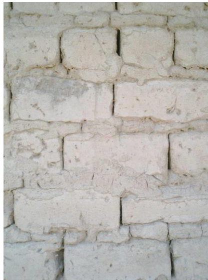
Figura 102. Detalhe da distribuição das fiadas “a vela” e “a tição” de adobe, na parede.
