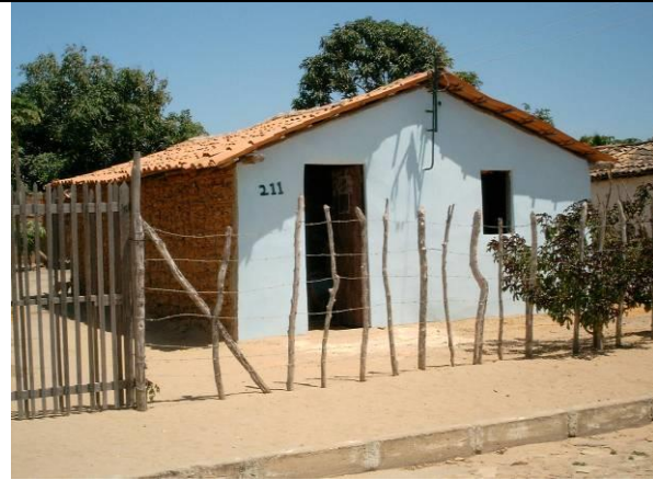
Figura 55. Vista da residência, em taipa de mão, na periferia de Parnaíba.
