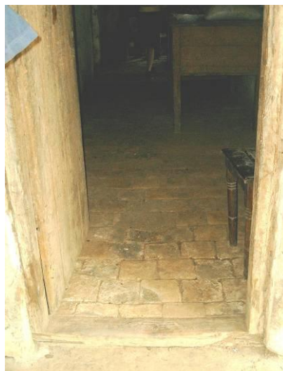
Figura 122. Detalhe da forra da porta em madeira e do piso original em ladrilho cerâmico.
