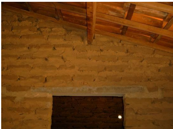
Figura 74. Detalhe da verga de concreto sobre o vão da porta.
