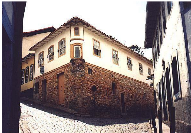
Figura 13. Alvenaria de pedra+taipa, solução tradicional arquitetura colonial brasileira. Fonte: HABITARE, 2004
