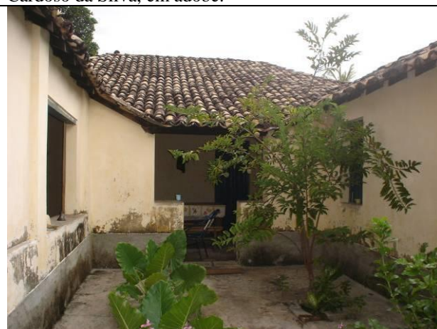
Figura 134. Vista do pátio interno e do telhado cerâmico da planta em formato “U”.
