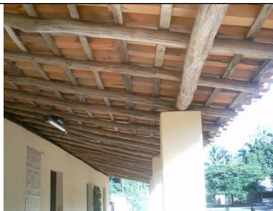
Figura 116. Vista da cobertura cerâmica sobre madeiramento de paus roliços.
