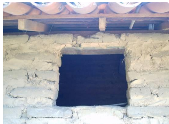
Figura 75. Detalhe da tábua colocada no vão do cobogó, que será retirada posteriormente.
