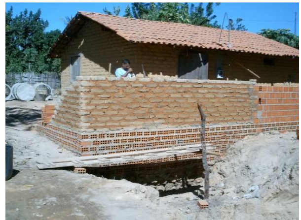
Figura 40. Fundação em pedra e baldrame em tijolo cerâmico de furo.
