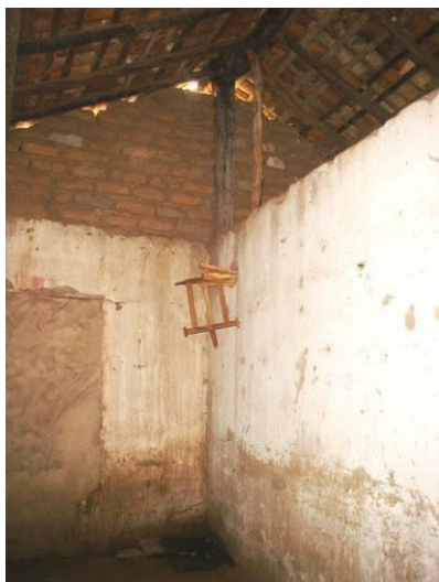
Figura 121. Vista da estrutura de cobertura em aroeira e pau-d'arco, embutida na parede. Foto: Wilza Lopes, 2006
