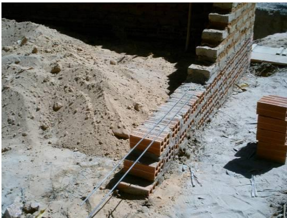
Figura 39. Barra de aço colocada na argamassa de assentamento do adobe.
