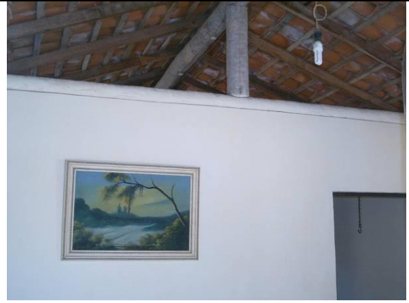
Figura 68. Detalhe interno da estrutura de madeira de carnaúba.
