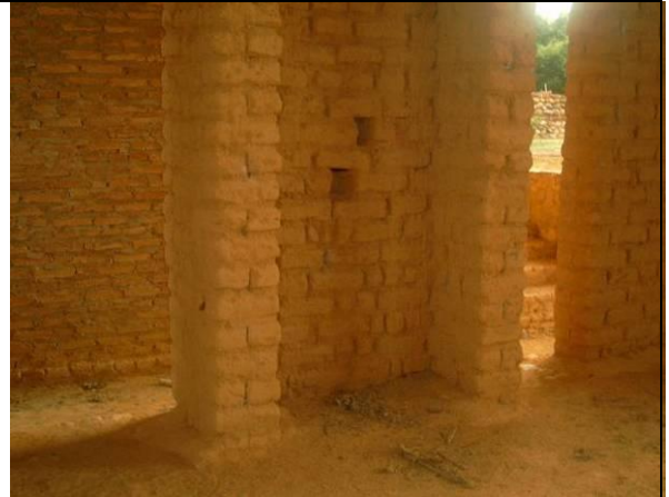
Figura 92. Parede de adobe seguida de parede de tijolo cerâmico maciço.
