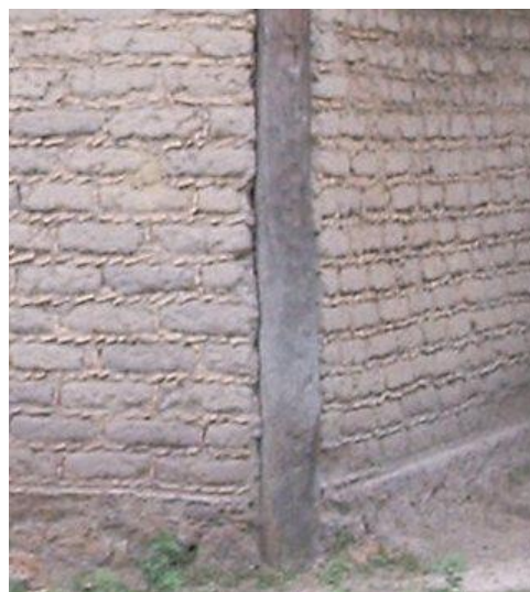
Figura 124. Detalhe do emechamento dos cacos de telha na argamassa de assentamento dos adobes.
