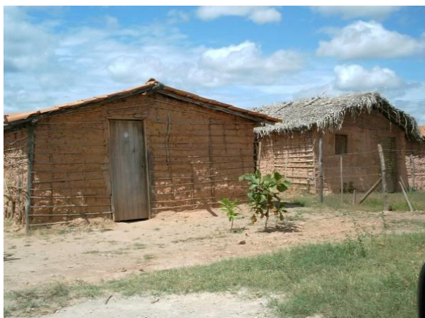
Figura 140. Exemplos de construções em taipa de mão, encontradas na periferia da cidade, executadas sem nenhum cuidado ou rigor técnico.
