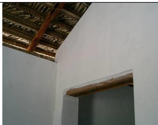
Figura 130. Detalhe da verga em madeira utilizada sobre os vãos das portas internas.
