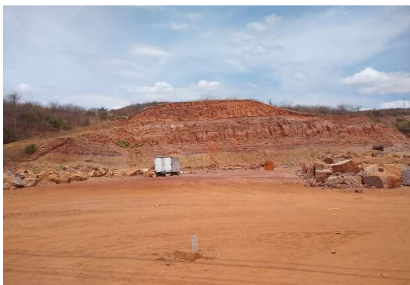
Figura 18: corte de encosta no perímetro urbano de Picos
