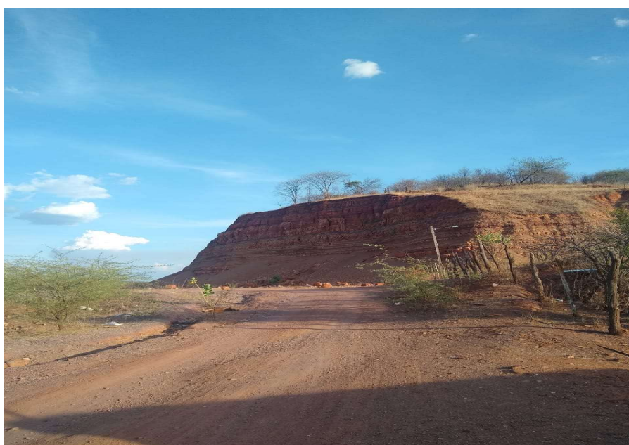
Figura 19: corte de encosta no perímetro urbano de Picos
