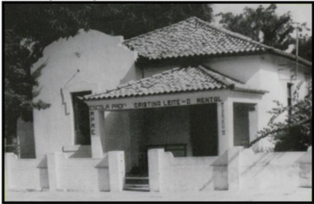
Figura 17: Segundo Prédio de Funcionamento da EEEPCP em 1971
