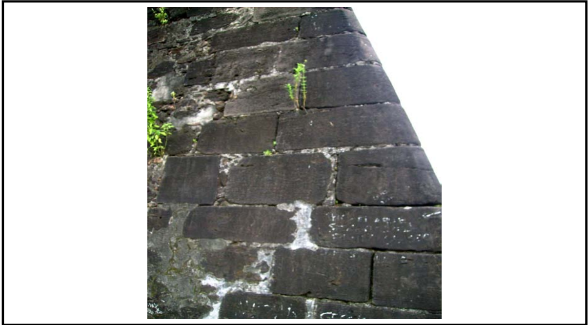
IMAGEM IV: Fotografia atual dos pilares de sustentação da Fortaleza de São José de Macapá. Observa-se que eram usadas as pedras lapidadas para seu contorno e ornamento. Edificação original, sem nenhuma ou recuperação posterior. Fonte: Arquivo da Jornalista Dulcivânia Gomes Freitas- (03.2009).
