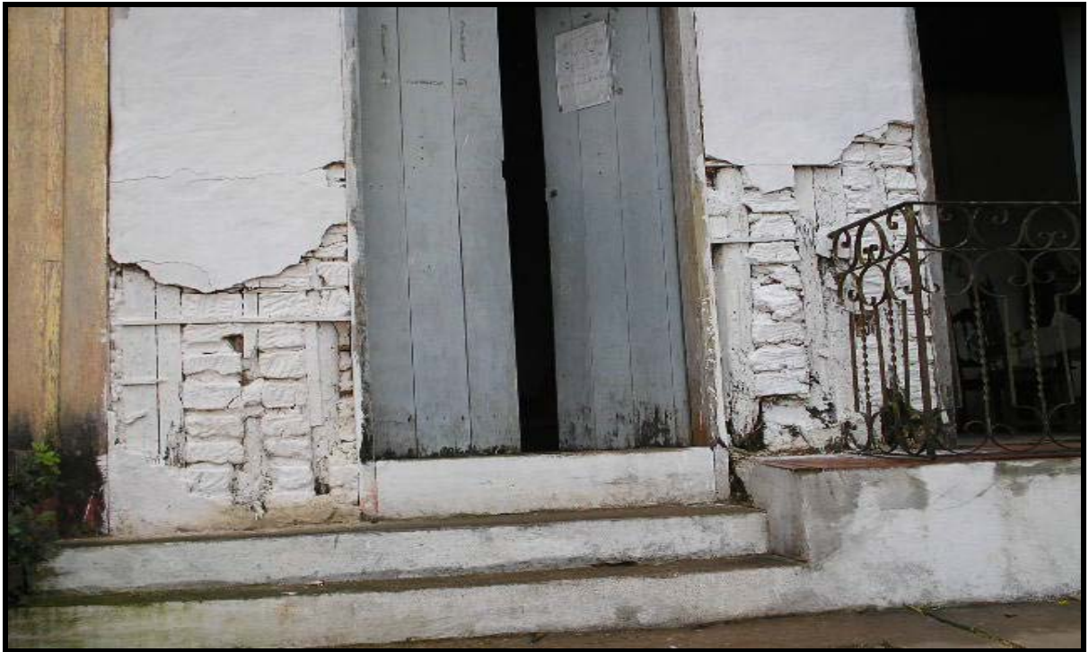
IMAGEM I: Fotografia atual de uma casa construída no final do século XVIII, provavelmente entre 1770-1775 em Mazagão Velho, terceira vila a ser criada na Região de Macapá depois da vila São José de Macapá, em Tijolo de adobe, técnica construtiva bastante usada na segunda metade do século XVIII. Fonte: Arquivo particular da autora (2006).
