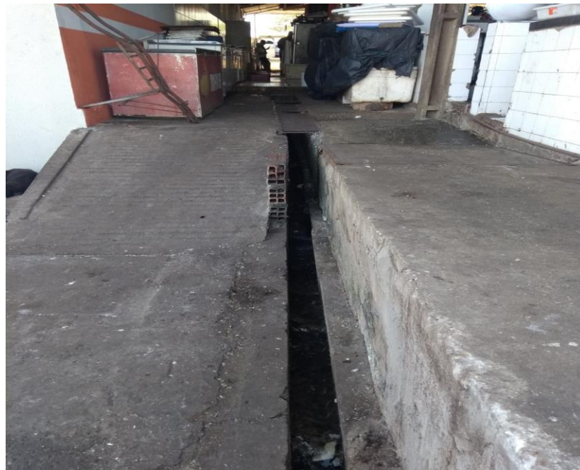
Figura 20. Canaleta do setor de varejo do mercado do peixe deTeresina, PI. Fonte: Arquivo pessoal (2021)
