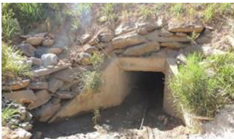
Figura 38 – Passagem de Fauna adotada na obra de duplicação da BR-381/MG no ano de 2020
