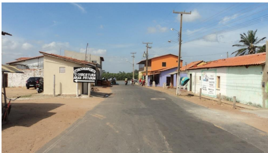
Figura 15 – Via de acesso dos visitantes no Porto dos Tatus
