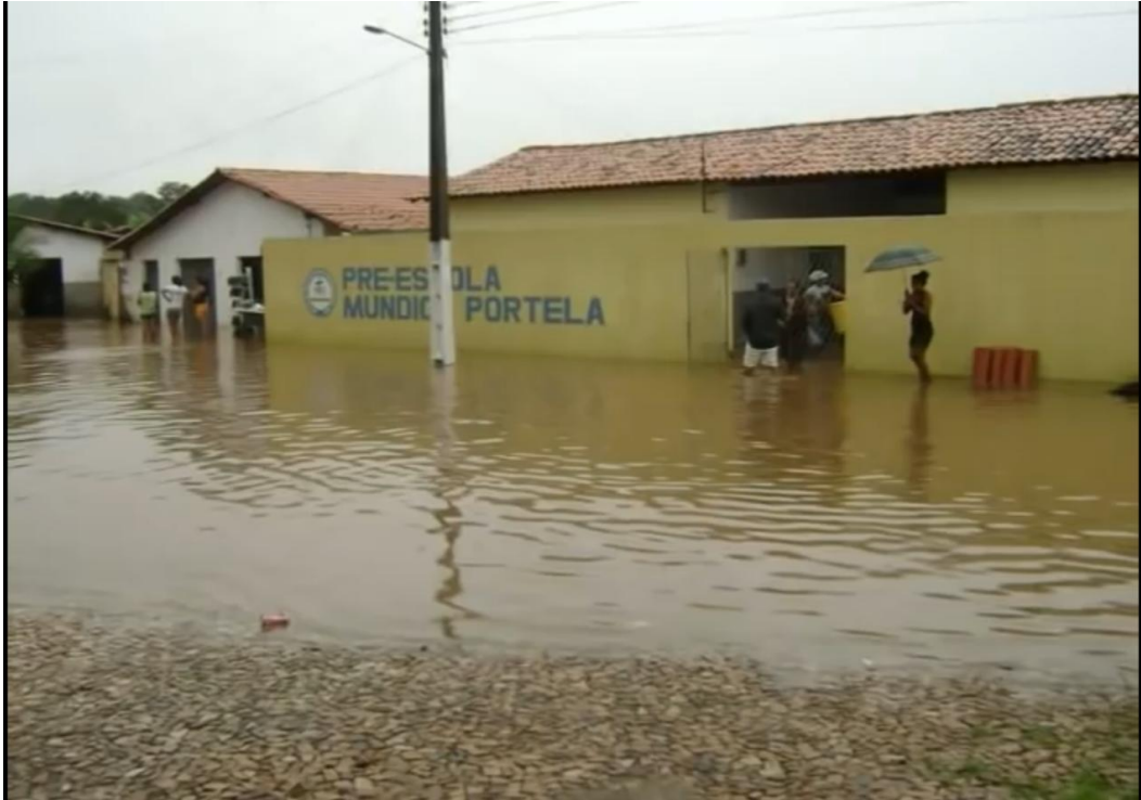
Figura 15: Alagamento na Pré Escola Municipal Mundica Portela em 2009.
