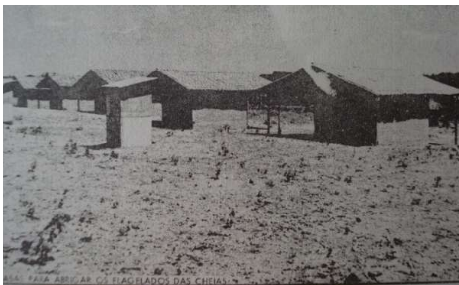
Foto 16: Casas para abrigar os flagelados das cheias construídas no bairro Buenos Aires.
