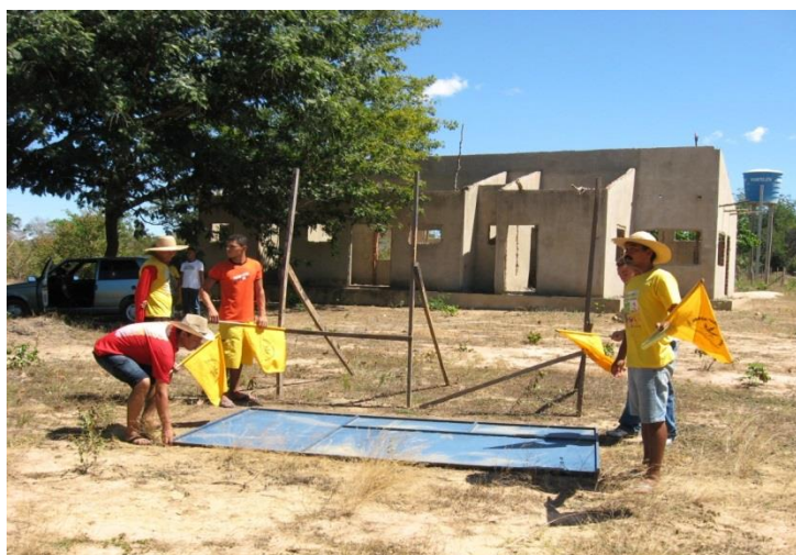
Figura 21 – fiscalização da obra de construção do matadouro público do município de Floriano.
