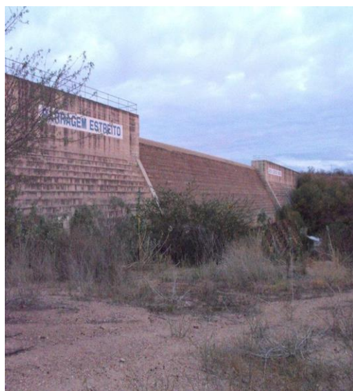
Figura 26 – Obra da barragem do Estreito, Município de Francisco Macedo-PI. Fonte: Arquivo FTP (2012)
