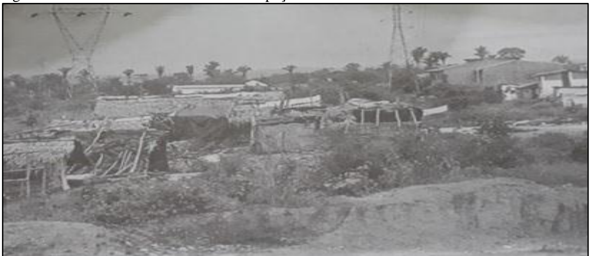
Figura 12 – Favela Francisco Alencar: ocupação em área de risco.
