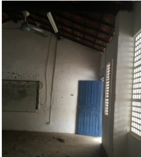
Figura 23 – Vista da segunda sala
