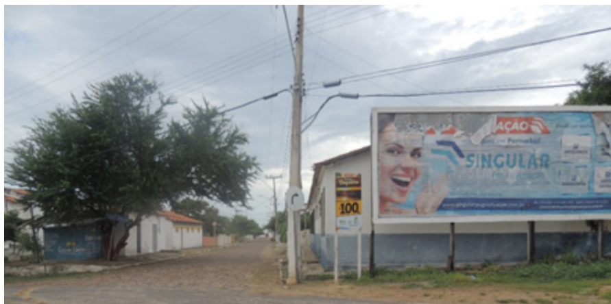
Figura 26 – Fachada Lateral Direita
