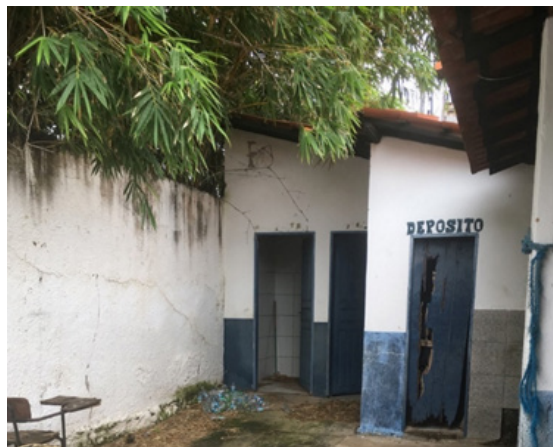
Figura 14 – Banheiros em reforma posterior à construção
