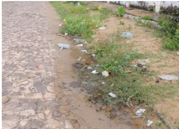
Figura 4 – Calçadas sem acessibilidade e lixos acumulados
