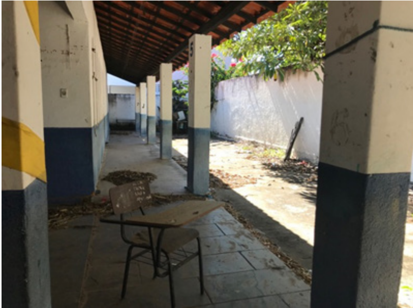
Figura 55 – Vista do pátio aberto – ANTES da Revitalização
