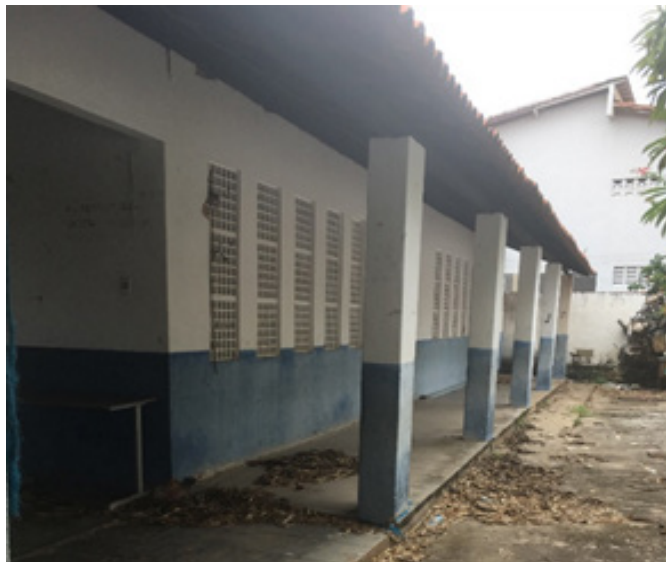
Figura 21 – Vista corredor de acesso as salas de aula
