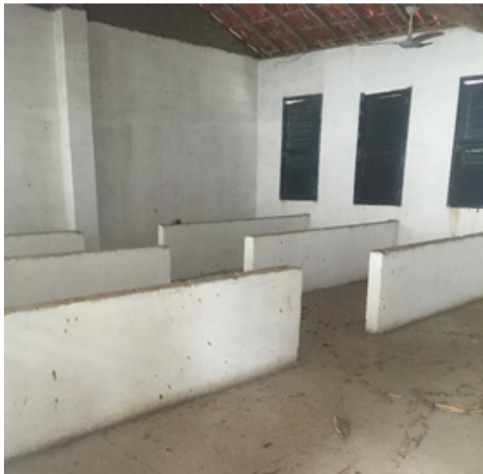
Figura 22 – Vista da primeira sala com suas divisórias
