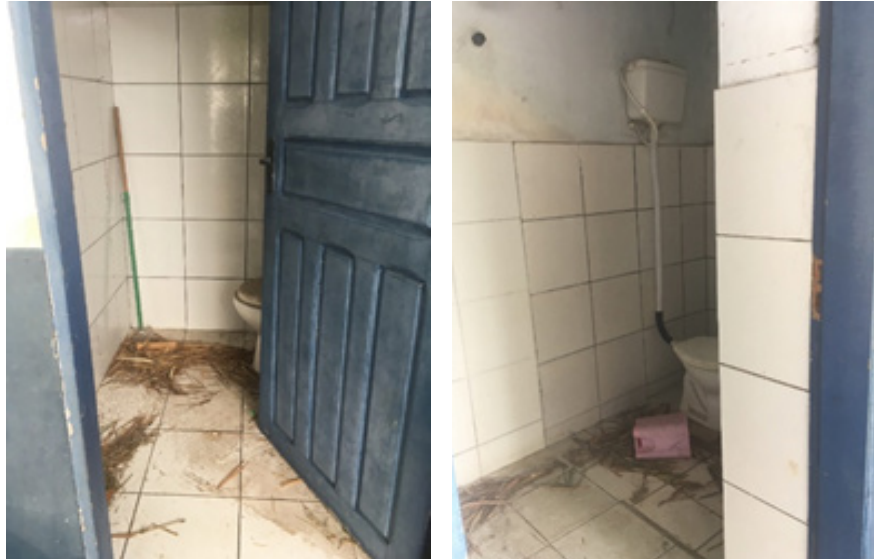
Figura 19 (esquerda) e Figura 20 (direita) – Vistas internas dos banheiros
