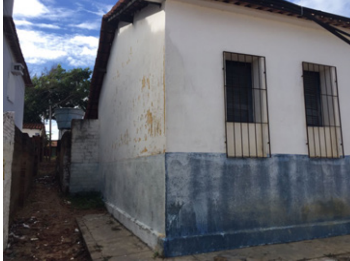
Figura 27 – Fachada Lateral Esquerda
