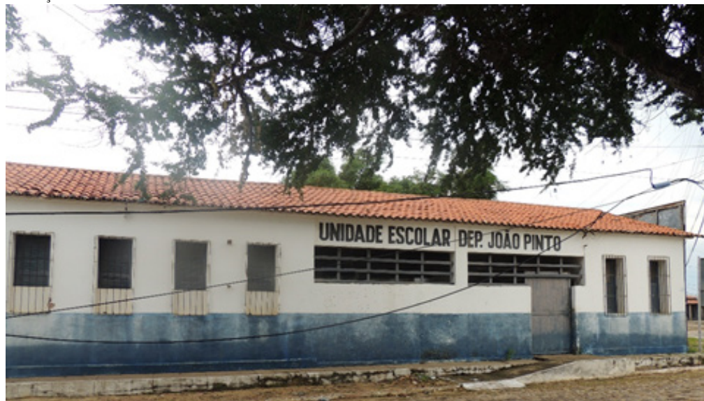
Figura 51 – Fachada Frontal com identidade visual das escolas estaduais – ANTES da revitalização
