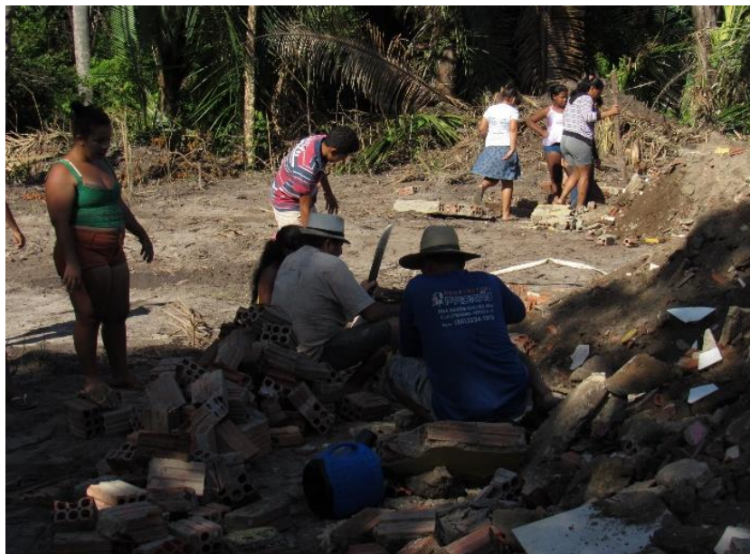
Figura 10. Mutirão para recuperar os materiais de construção para a nova sede em Fortaleza III, em 16/01/2018 (Autoria da pesquisadora)
