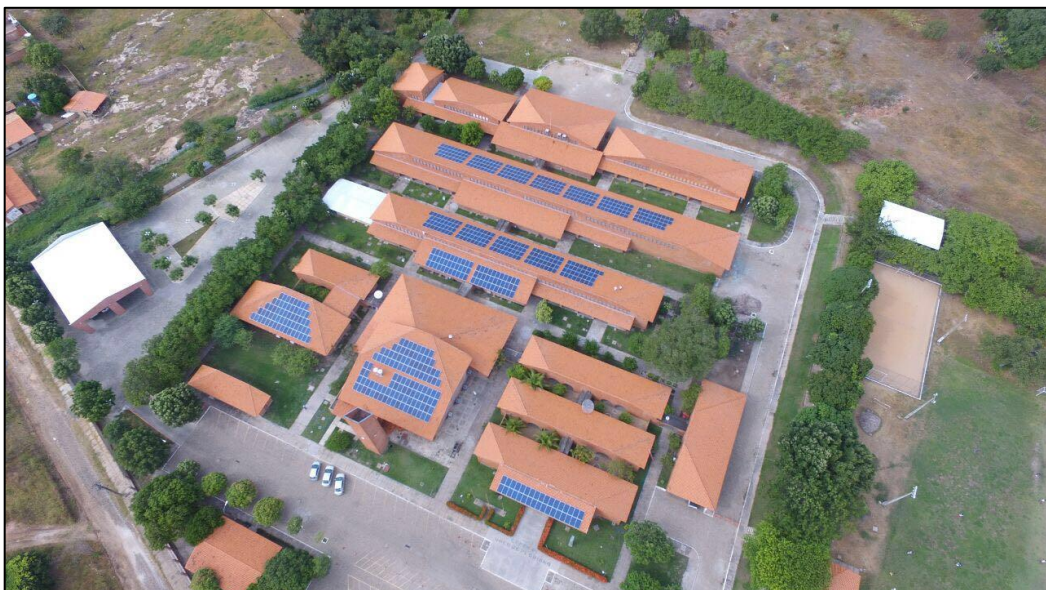
Figura 16 - Disposição dos módulos fotovoltaicos no telhado do Campus Floriano
