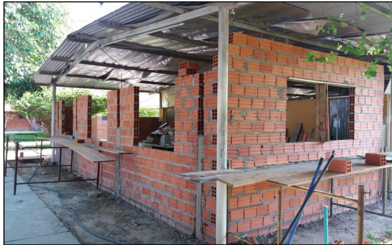
Figura 30 - Obra em andamento do laboratório de energia solar fotovoltaica
