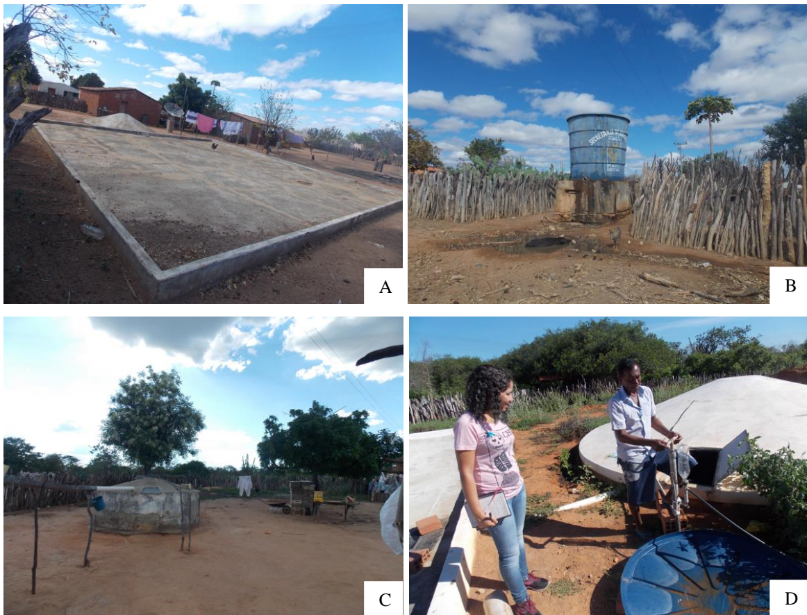
Fotografia 13 - Formas de obter água. A- cisterna calçadão. B- poço da prefeitura. C- cisterna de placas. D – bomba para irrigação dos “canteiros”
