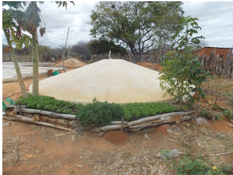
Fotografia 21 – “Canteiro” ao redor da cisterna
