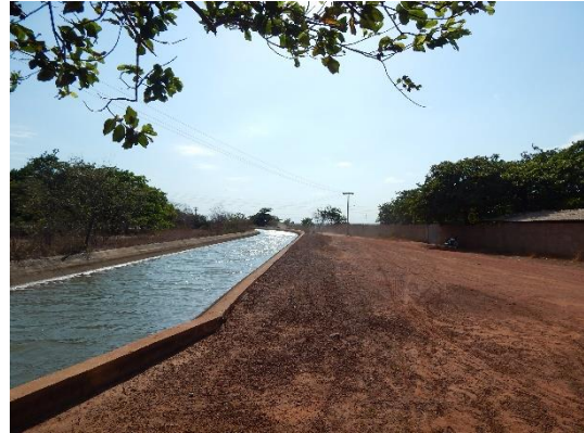
Início do Canal de Irrigação
