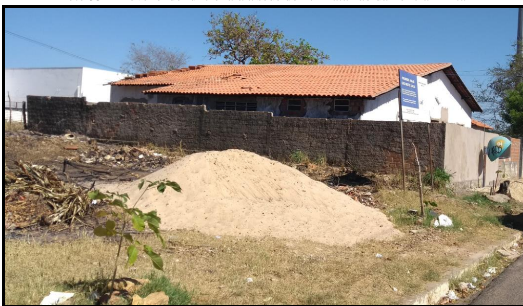
Foto 33 - Imóvel onde funcionará a sede do 17º Batalhão da Polícia Militar
