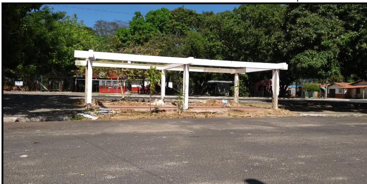
Foto 26 - Posto de Policiamento Ostensivo desativado no bairro Acarape
