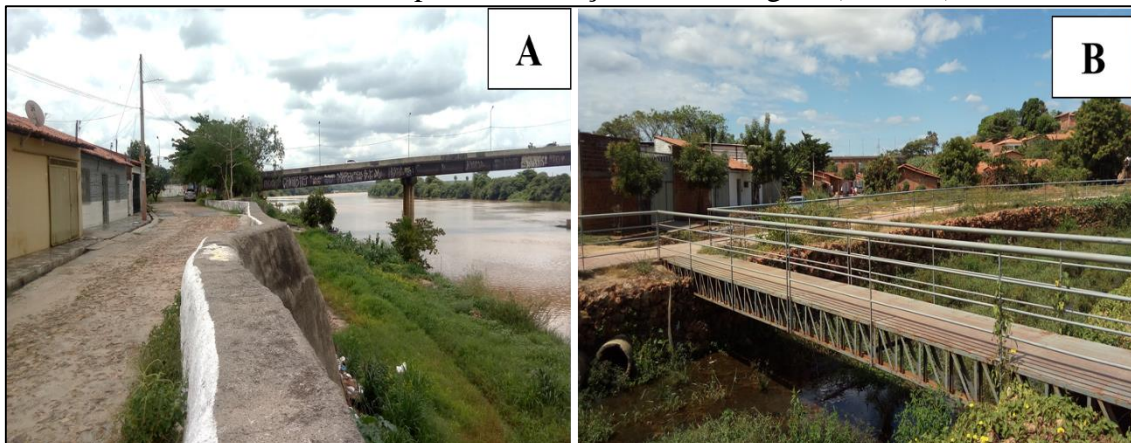
Figura 78 – Setores classificados como alta vulnerabilidade ambiental. Em A, ausência de preservação e respeito à APP (localizado no setor 4); e em B, curso hídrico canalizado e com pontos de lançamento de esgoto (setor 33)
