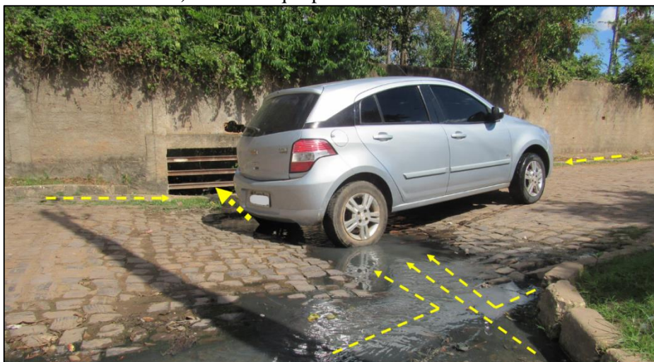
Figura 68 – Esgoto a céu aberto no setor censitário 63 (bairro Parque Poti, região Sudeste de Teresina) com destaque para o sentido do escoamento
