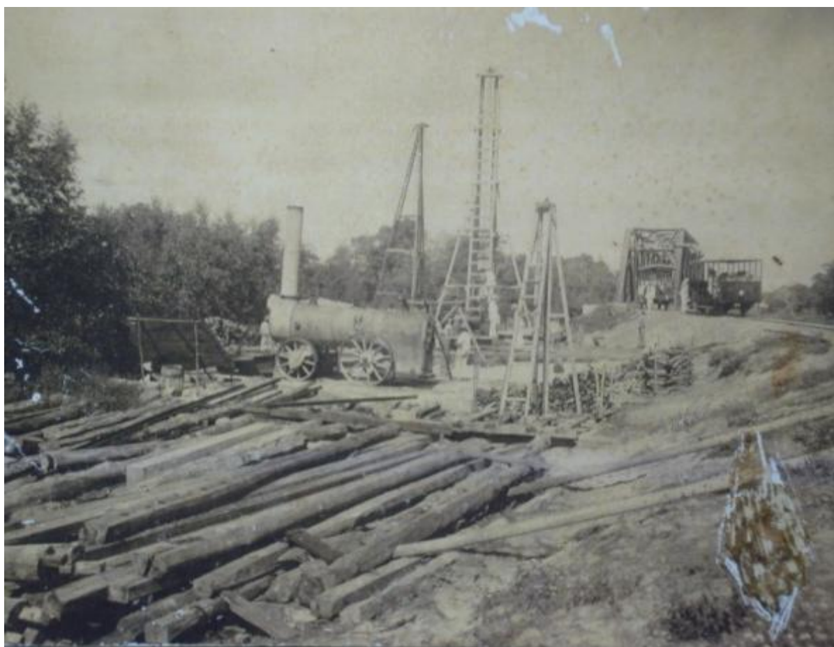
Fotografia 10: “Estrada de Ferro Central do Piauí, Ponte do Portinho – vão total: 130 m. Bate-estacas a vapor no serviço de fundação do último encontro – junho – 1922”.
