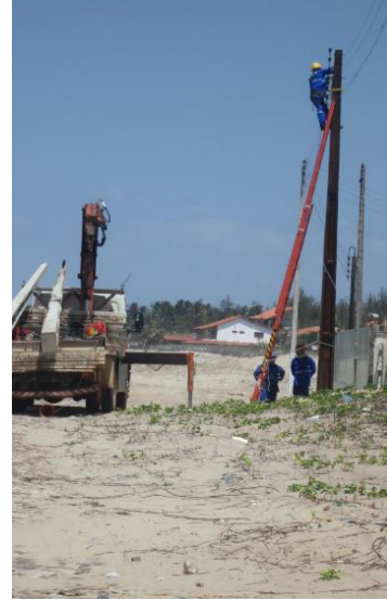
Figura – 14: Instalação dos postes com resina na praia Peito de Moça – Luís Correia - PI
