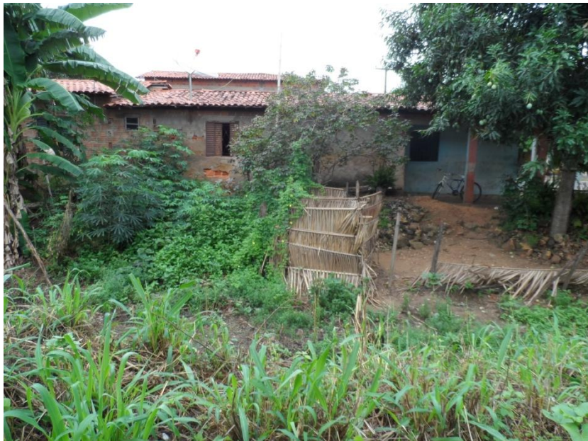
Figura 14. Residência localizada dentro da mata no bairro Santa Teresa, Teresina/PI, demonstrando as condições precárias e de total inexistência de banheiro com instalações sanitárias básicas.
