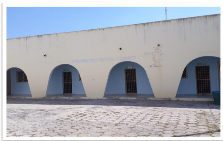
Imagem 3: Acesso às salas de aula
