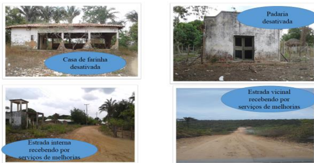
Figura 30 - Desativação da casa de farinha, padaria; Condições das estradas internas e vicinais do PA Buenos Aires.
