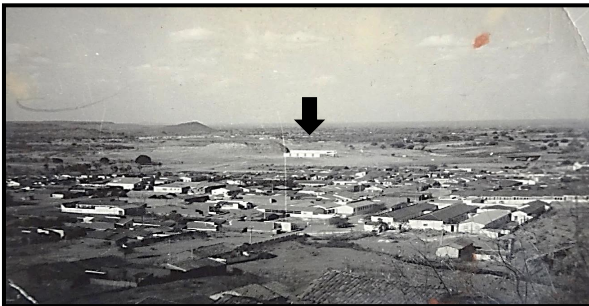
Figura 37: Localização do prédio do GEP (1970)
