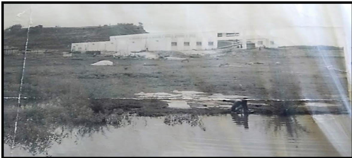
Figura 42: Construção da quarta sede do ginásio de Picos
