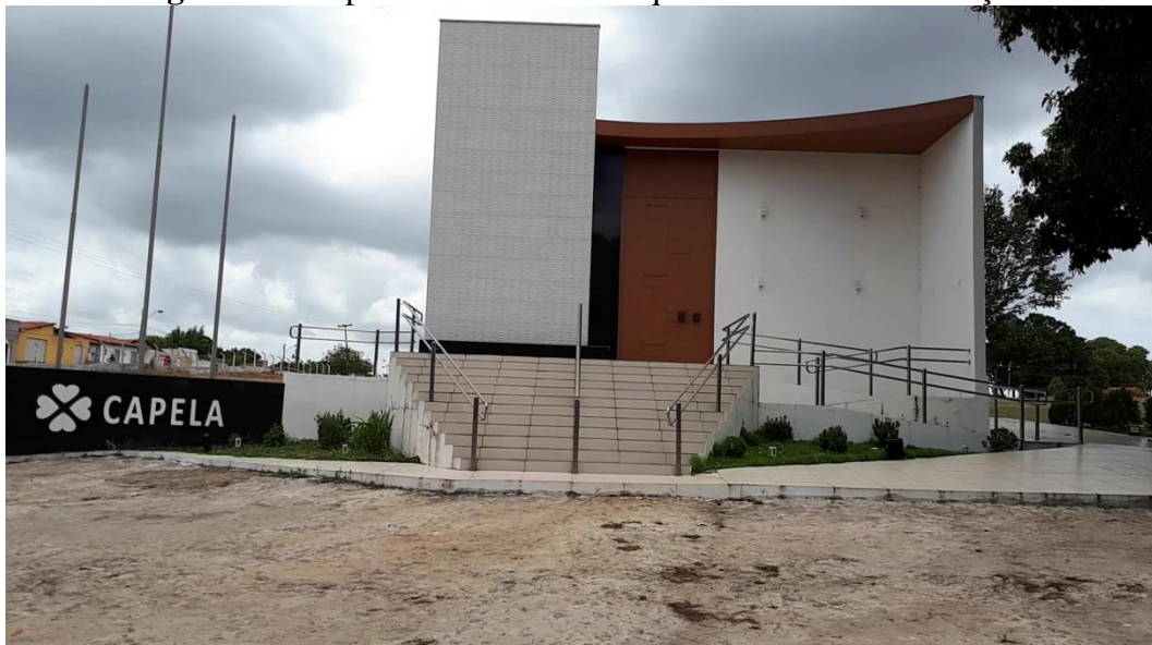
Figura 34. Capela do cemitério Parque Jardim da Ressurreição
