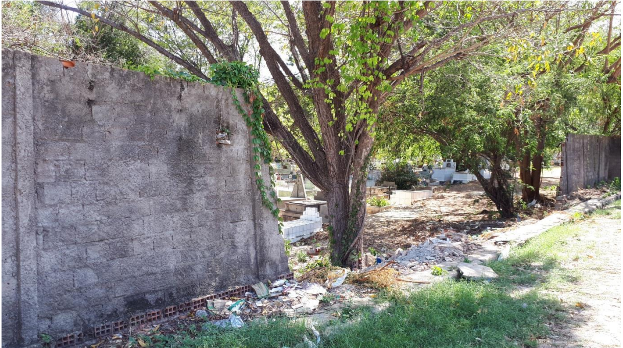
Figura 4. Muro caído encontrado no cemitério Santa Cruz
