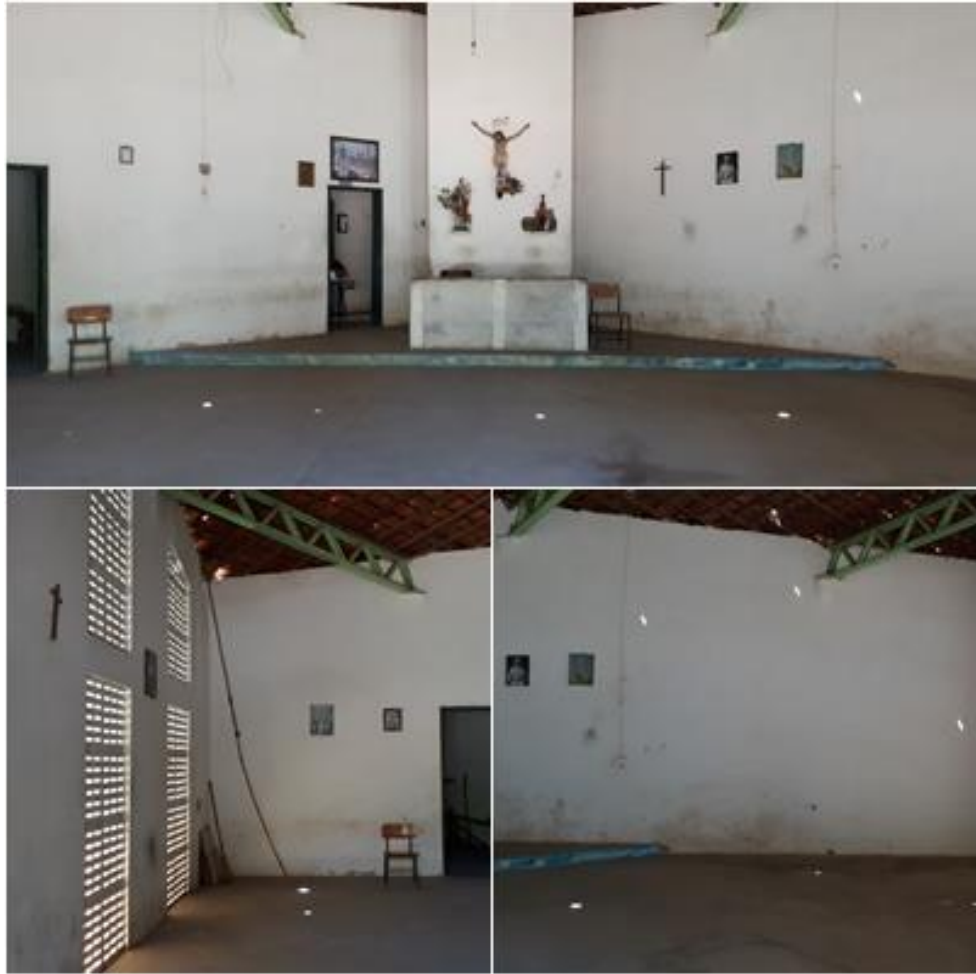
Figura 9. Parte interior da capela do cemitério Santa cruz
