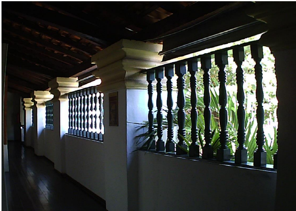
Figura 13 – Varanda da casa do Barão de Gurguéia
