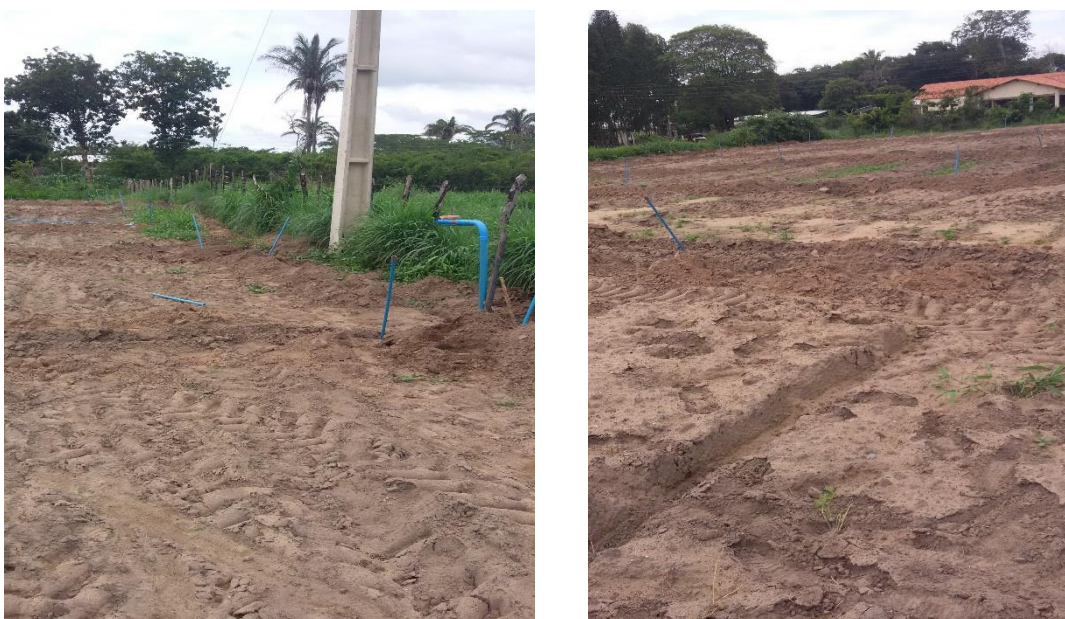
Figura 2 Instalação do sistema de irrigação por aspersão na área experimental (Fonte: O autor).
