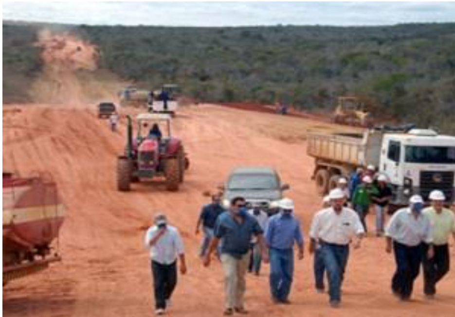
Figura 08: Construção da Transnordestina.
