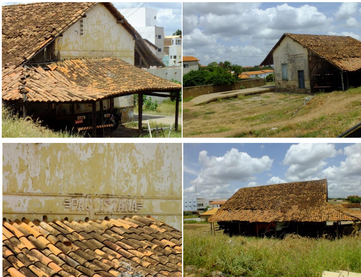
Figura 14 – Instalações da antiga Estação ferroviária Petrolina – Paulistana
