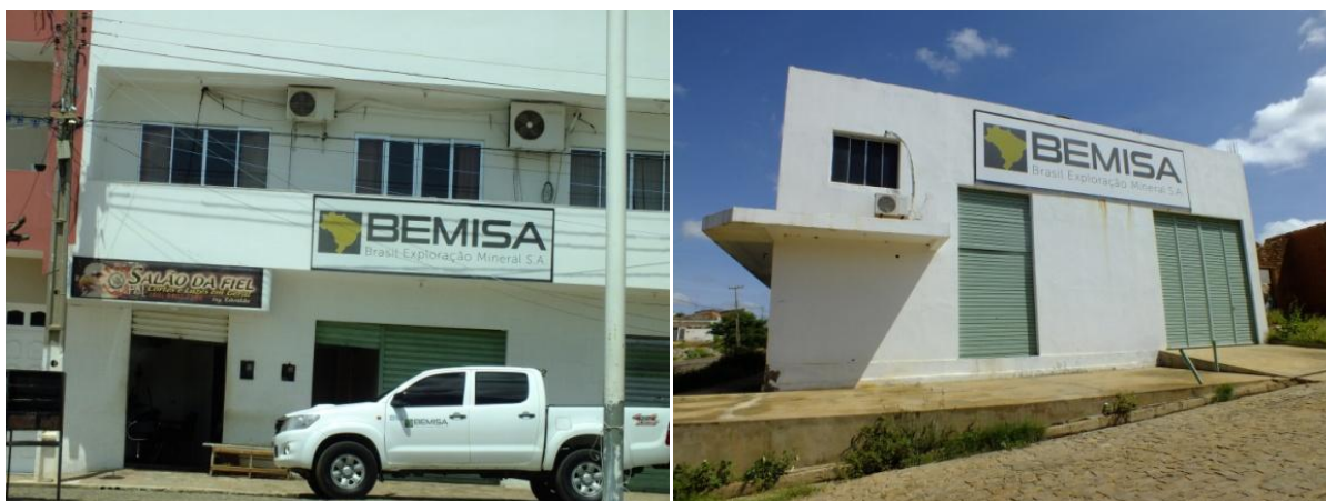
Figura 16 – Escritório e galpão da mineradora BEMISA em Paulistana-PI
