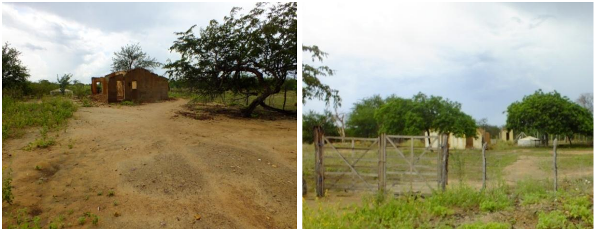
Figura 26 – Casas desapropriadas e danificadas pela construção da ferrovia Transnordestina na Comunidade Contente
