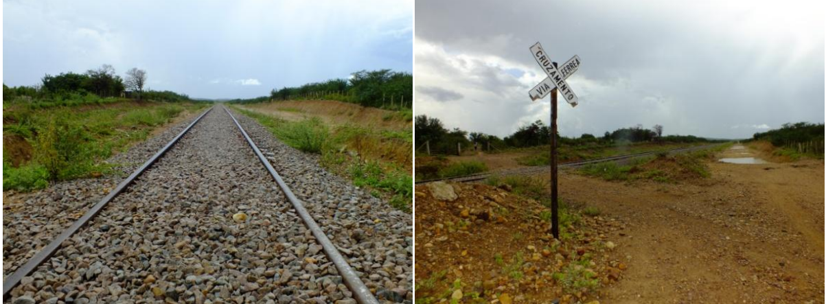
Figura 25 – Trecho da ferrovia Transnordestina que corta a Comunidade Contente
